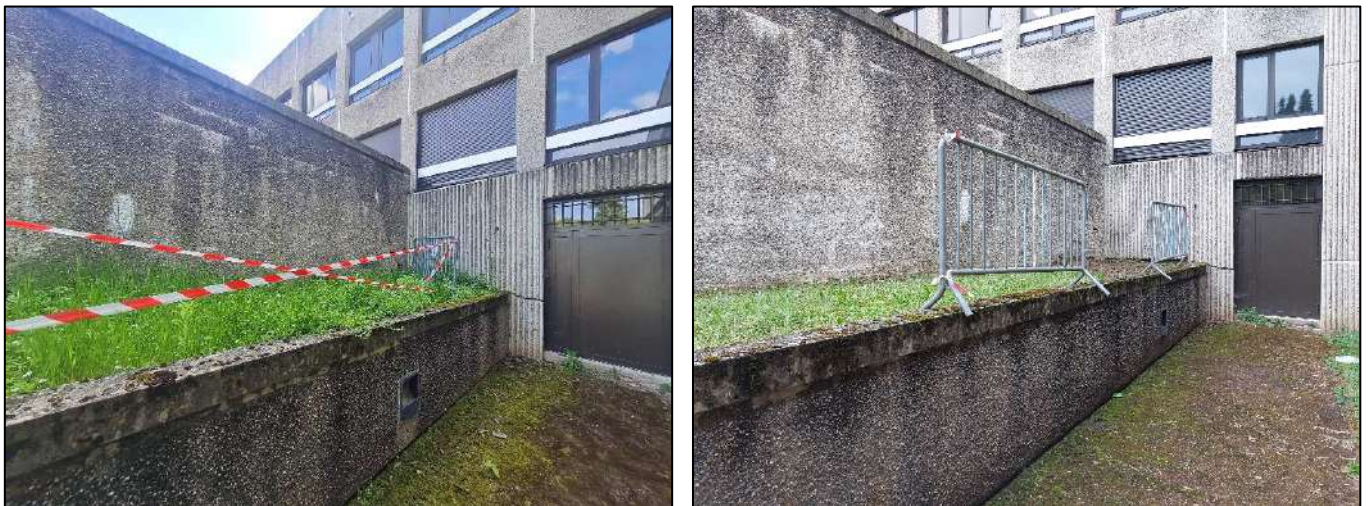
Figure 6 : Photographies de l'affaissement principal de la terrasse de puis le bas (à gauche 19/05/2024 – à droite 28/05/2025)
