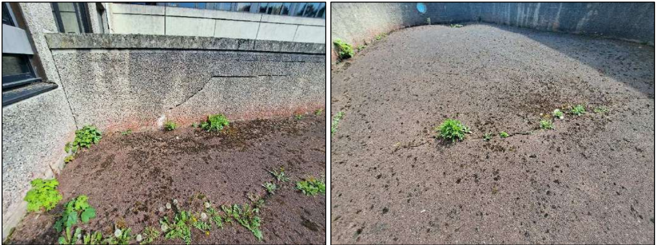
Figure 7 : Photographies de l'affaissement principal de la terrasse de puis le haut (27/06/2024)
